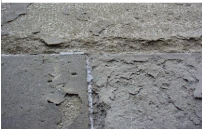
Abb. 1: Ausschnitt einer hydrophobierten Schilfsandsteinfassade, an der sich die Oberfläche wie eine dünne Tapete abgelöst hat. Das freiliegende Gestein sandet. (Photo: J. Meinhardt).
