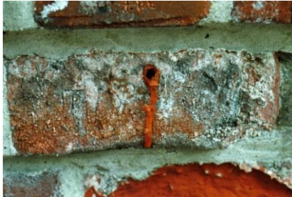
Abb. 4: In Extremfällen fließt nach einer Spiralbohrung durch die hydrophobierte Oberflächenzone das dahinter aufgestaute Wasser aus dem Bohrloch heraus (Photo: MPA Bremen).
