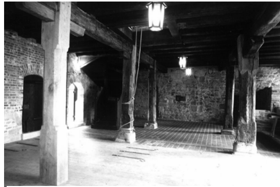
Sanierte Scheune (Innenansicht)
