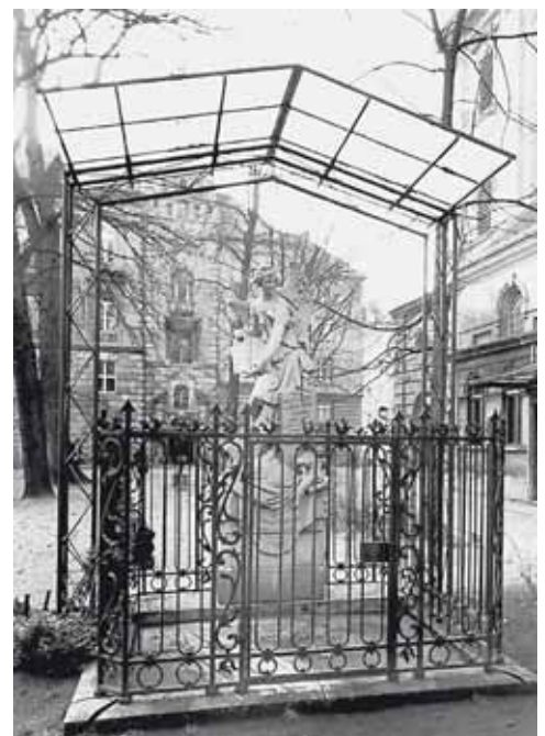
Abb. 4. Überdachung eines Grabdenkmals als Bewitterungsschutz
