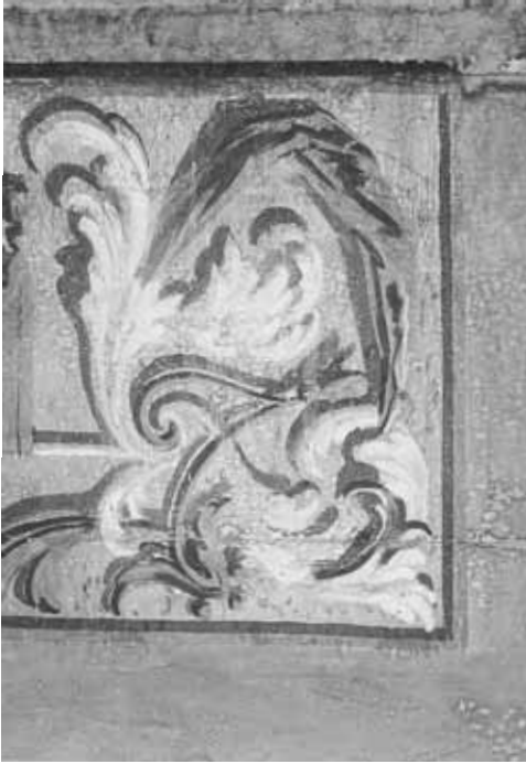
Abb. 2. Wasserflecken an einer farbig gefassten Holzbrüstung, durch nasses Wischen verursacht
