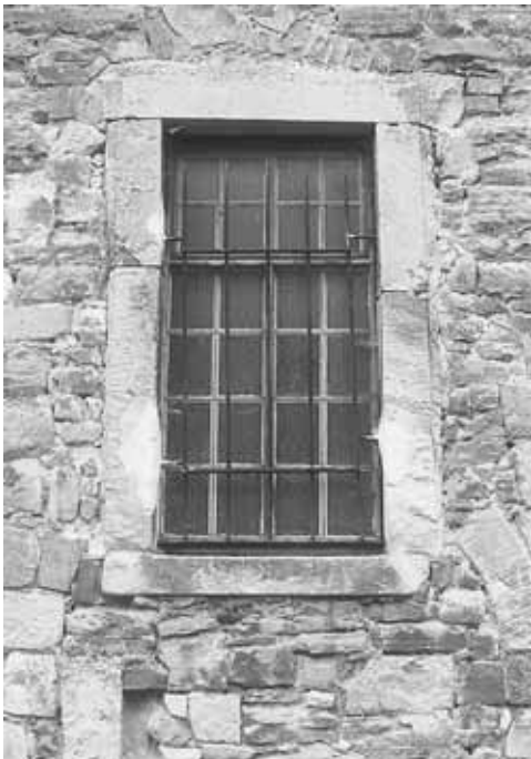
Abb. 7. Ungenügend, nur an vier Punkten im Mauerwerk verankertes Fenstergitter, das bei einem Diebstahl ausgebrochen wurde
