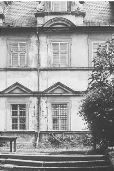
Abb. 10. Bauschaden durch defektes Fallrohr
