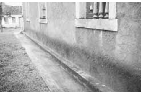
Abb. 16. Algenbewuchs am Gebäudesockel deutet auf schädliche Wassereinwirkung
