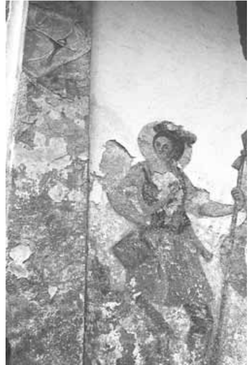
Abb. 23. Zerstörung einer Wandmalerei durch Feuchtigkeit. Vor der Restaurierung muss die Schadensursache behoben werden
