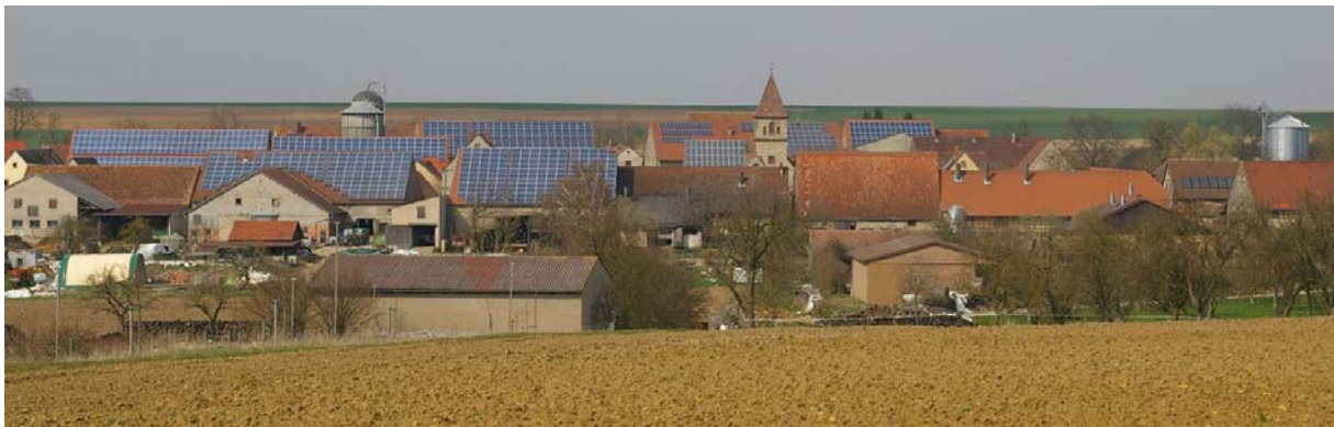
Abb.36 Gesamtanlage ohne Satzung.
