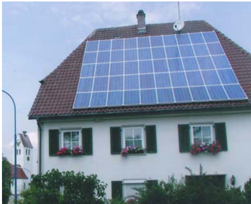
Abb. 87 40m 2 Kollektorenfläche bedecken das Dach und damit ein Gestalt bestimmendes Bauteil eines durchschnittlichen Wohnhauses zum überwiegenden Teil.
