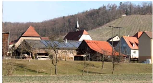
Abb.22 Ehemaliger klösterlicher Wirtschaftshof mit mittelalterlichem und frühneuzeitlichem Baubestand Erscheinungsbild:
