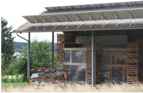
Abb.77/78, nicht dachparallele Systeme
