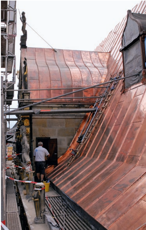
Bremen, Schütting, Rekonstruktion des Kupferdaches
