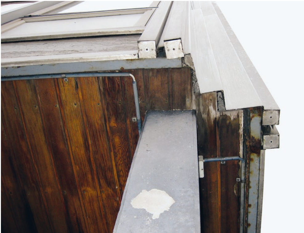
Bremen, Staatsarchiv, verzogene Vorhangfassade
