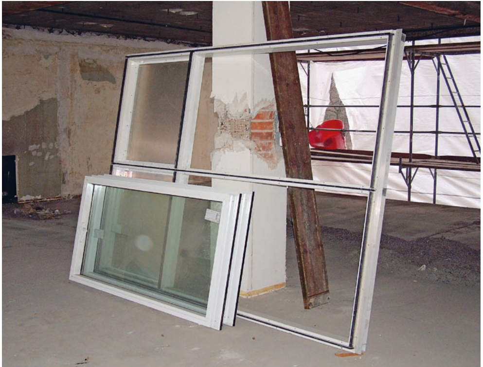
Bremen, Amerikanisches Generalkonsulat, während der Sanierung mit neuem Fenstermodul
